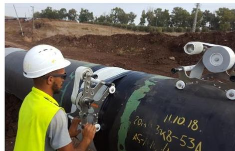
Das **Kebutyl-System C 50-C** ist ein kaltverarbeitbares Zweiband-Korrosionsschutzsystem nach DIN EN 12068, DIN 30672 und ISO 21809-3. Es besteht aus dem haftvermittelnden **Kebutyl-Voranstrich K III**, dem **Kebulen-Band 1,2 H** (Innenlage) und dem **Kebulen-Band PE 0,50** (Außenlage).
